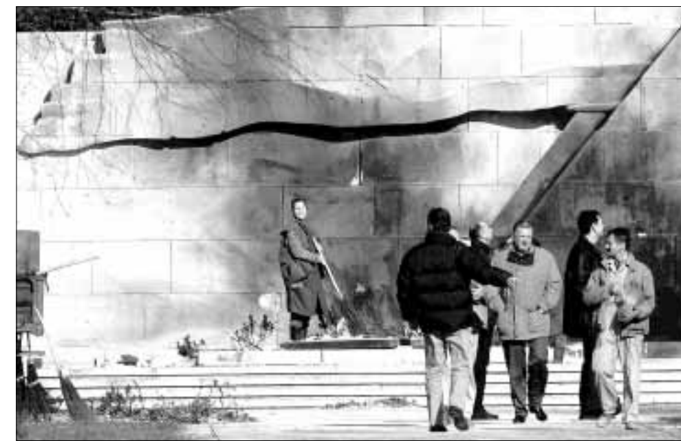
Mirogoj: Potrebna je potpuna demontaža spomenika
